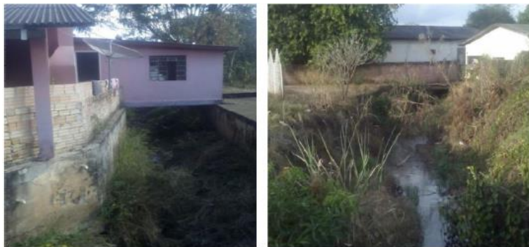
Figura 3. Construção de moradias sobre o leito do córrego obstruindo a drenagem.
